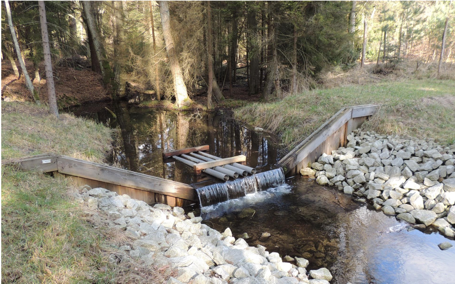
Przykład zabezpieczenia obiektów przed bobrami w Nadleśnictwie Torzym
